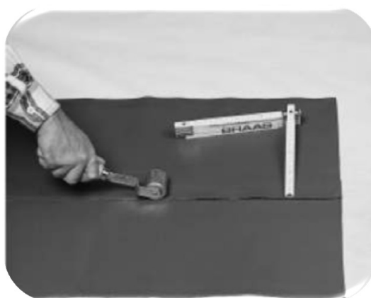
15.90 pav. Suformuoti ir nukirpti juostos kraštai užlenkiami ant kamino priekinės sienelės
