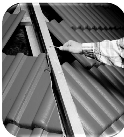
15.52 pav. Čerpės tvirtinimas prie kraigo
