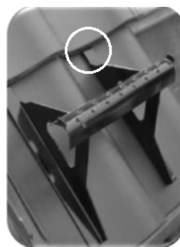
15.34 pav. Pripjauta čerpė įrengiant sniego užvarą
