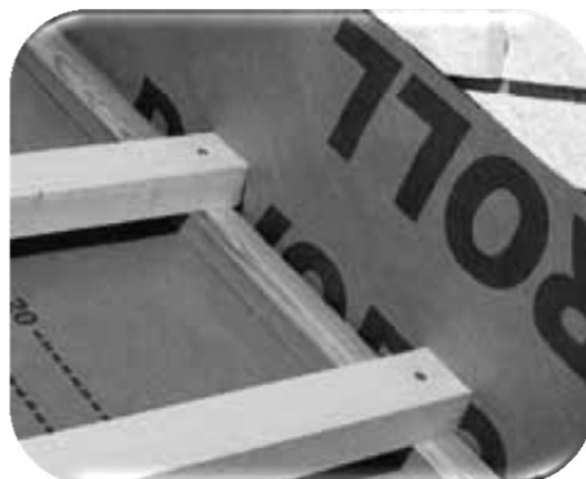
15.21 pav. Grebėstų įrengimas stogo šlaito plokštumos ir vertikalaus paviršiaus sandūroje
