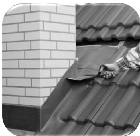
15.95 pav. Vertikaliai atkerpama nereikalinga juostos dalis iki kamino kampo
