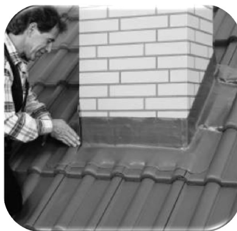
15.90 pav. Suformuoti ir nukirpti juostos kraštai užlenkiami ant kamino priekinės sienelės
