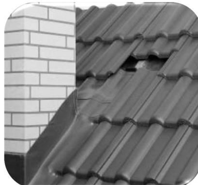
15.98 pav. Sandarinimo juosta suformuojama pagal čerpių profilį
