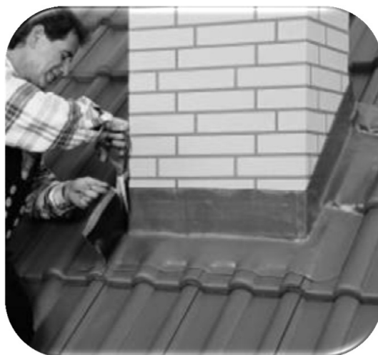
15.88 pav. Vertikaliai atkerpama nereikalinga juostos dalis iki kamino kampo
