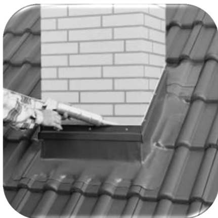
15.99 pav. Viršutinis profilio kraštas ir sujungimų užsandarinimas hermetiku
