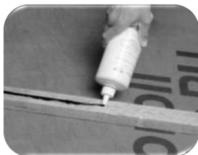
15.9 pav. Sandariklio tepimas ant ventiliacinių tašelių prieš juos montuojant
