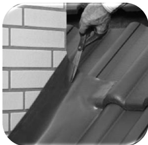
15.91 pav. Viršutiniame gale juosta įstrižai įkerpama iki kamino kampo
