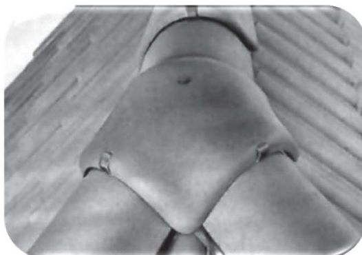
15.76 pav. Y čerpės montavimas
