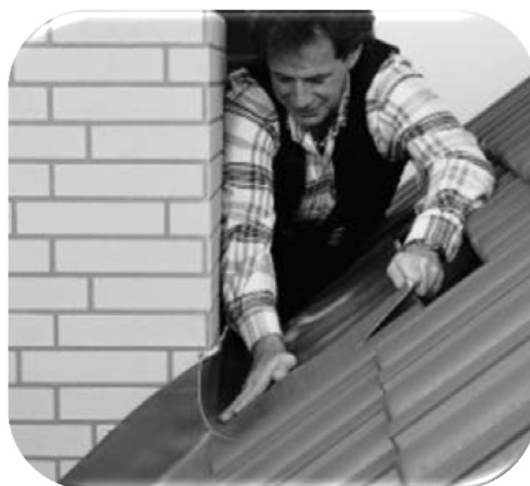
15.94 pav. Praplatinta juosta suformuojama pagal reikiamą kampą ir įstatoma į vietą už kamino
