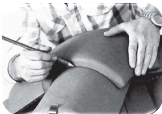
15.72 pav. Horizontalaus kraigo tarpinės įrengimas Y formos sandūroje
