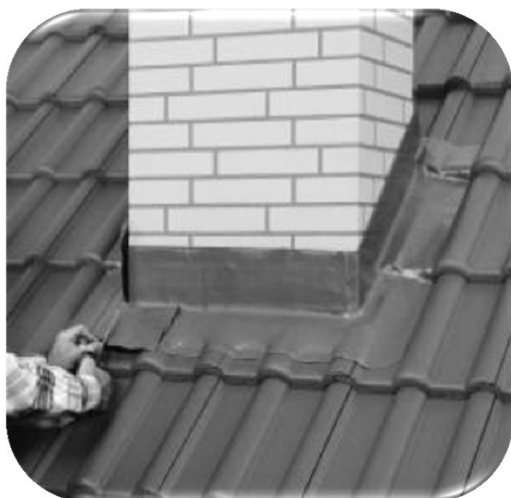
15.89 pav. Horizontaliai atkerpama nereikalinga juostos dalis
