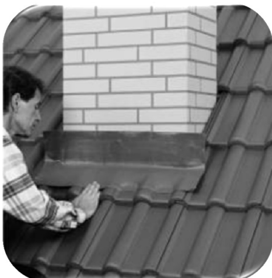
15.85 pav. Juosta suformuojama pagal čerpių profilį ir priklijuojama visu ilgiu
