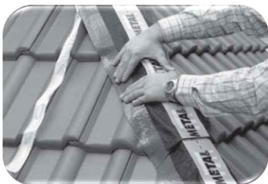
15.62 pav. Nuožulnaus kraigo ventiliacijai naudojama tik klijuojama sandarinimo juosta
