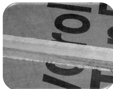
15.10 pav. ventiliacinių tašelių prispaudimas juos montuojant
