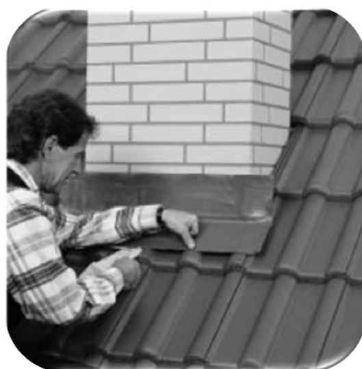
15.84 pav. Sandarinimo juosta fiksuojama čerpių bangų viršutiniuose taškuose
