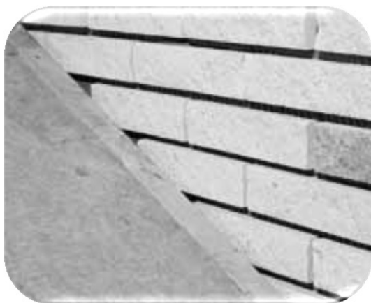
15.18 pav. Stogo šlaito plokštumos ir vertikalaus paviršiaus sandūra
