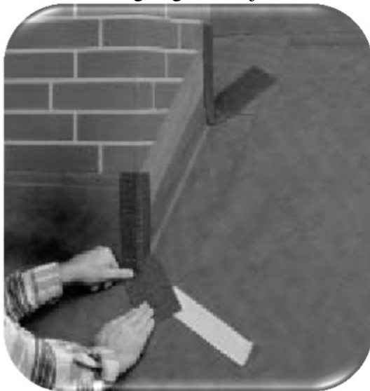
15.16 pav. Plėvelės užlenkimų prie kamino sandarinimas klijavimo juosta
