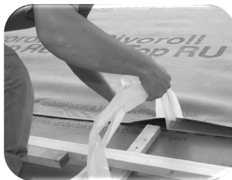
15.8 pav. Plėvelės juostų sandarinimas prispaudžiant
