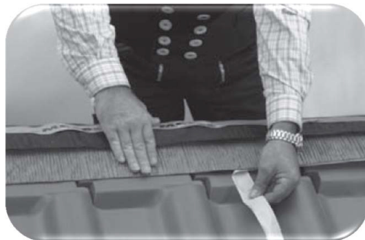
15.61 pav. Klijavimas per visa čerpės paviršių
