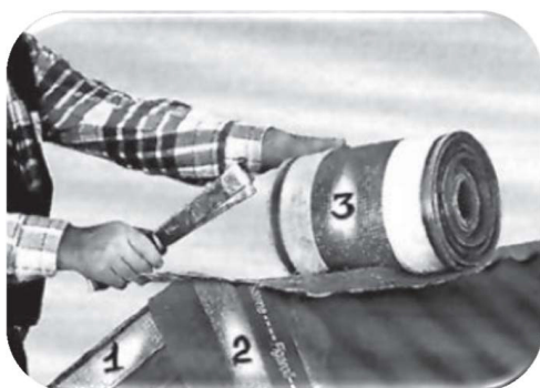
15.72 pav. Horizontalaus kraigo tarpinės įrengimas Y formos sandūroje
