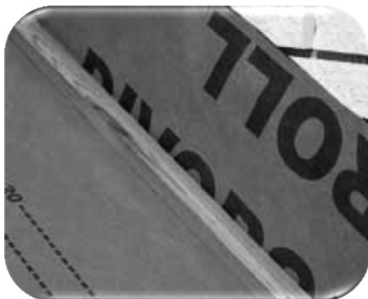
15.20 pav. Ventiliacinio tašelio įrengimas stogo šlaito plokštumos ir vertikalaus paviršiaus sandūroje
