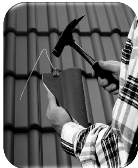
15.50 pav. Pjautos čerpės tvirtinimas
