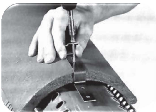
15.64 pav. Kraigo čerpės tvirtinimas aliumininiais kraigo laikikliais ir medsraigčiais
