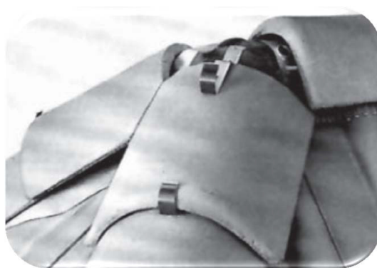
15.73 pav. Čerpių pripjovimas Y formos sandūroje
