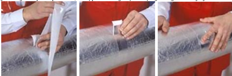
75 pav. Vamzdžių izoliavimas
