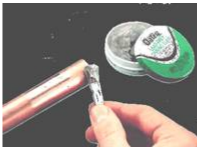
2 pav. Vamzdžių jungimas lituojant
