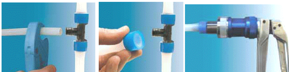
13 pav. Sujungimas presuojant
