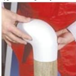
73 pav. Vamzdžių izoliavimas
